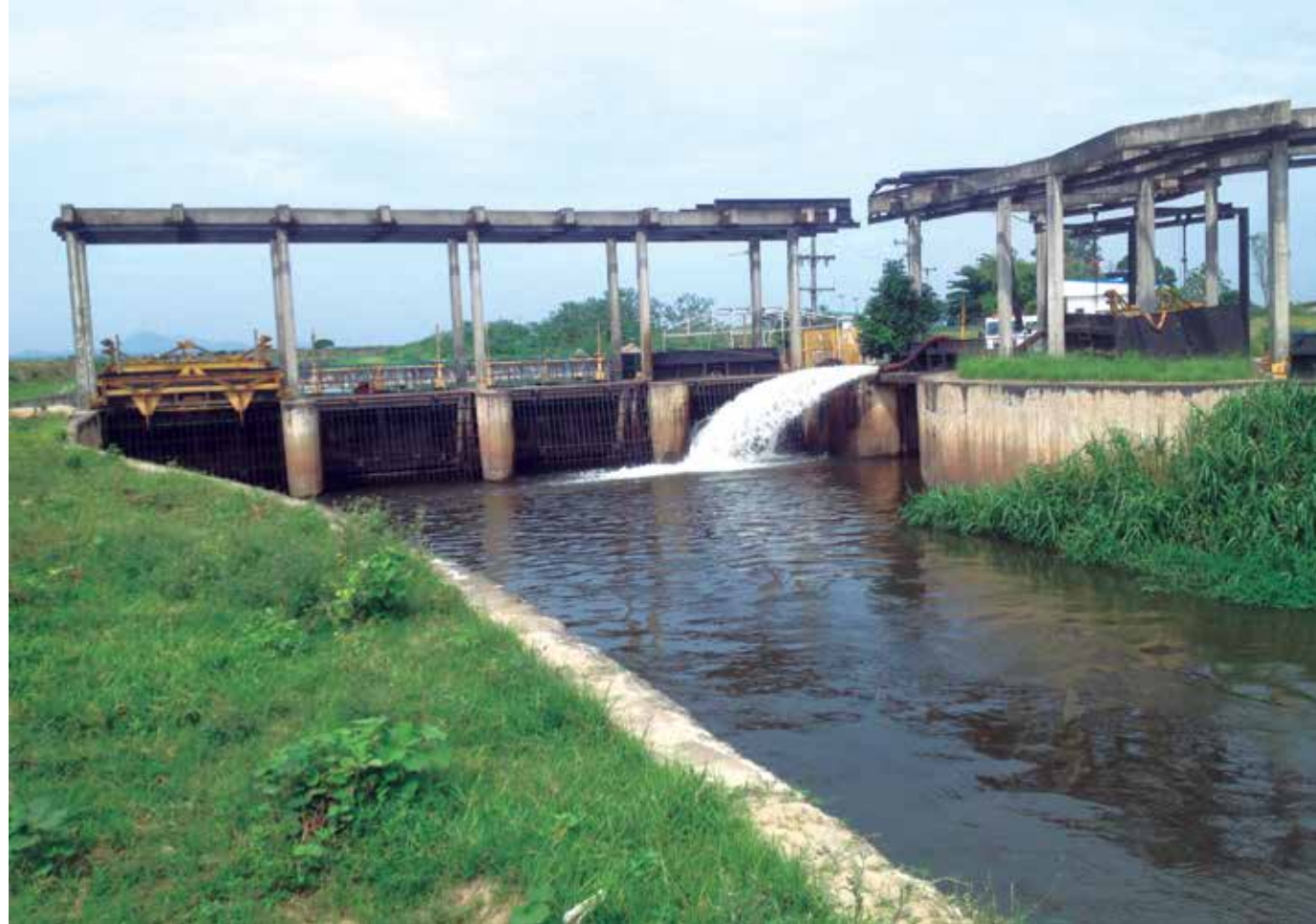
Área da captação de água para o Sistema Imunana-Laranjal (Foto: Subsecretaria de Segurança Hídrica/SEA)
