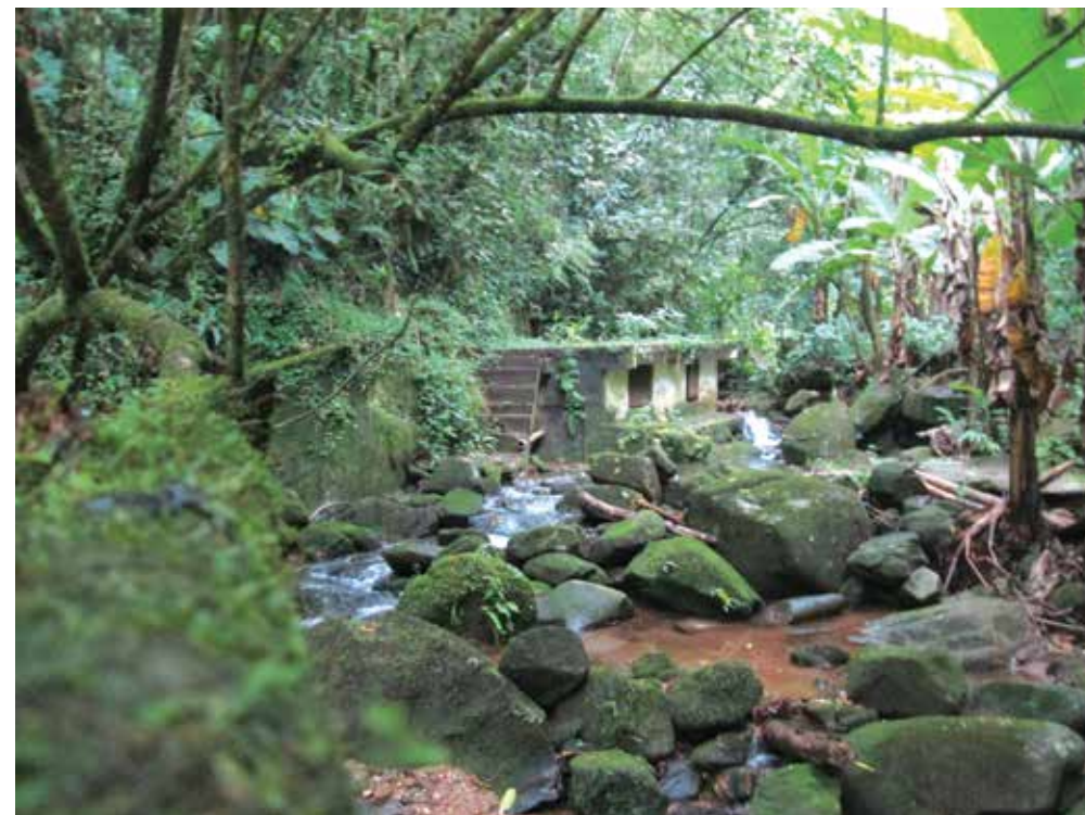
Pequena captação de água no interior do Parque Estadual dos Três Picos, em Cachoeiras de Macacu. Captação Tocas, no Rio Guapiaçu (Foto: Gabriel Ludolf)
