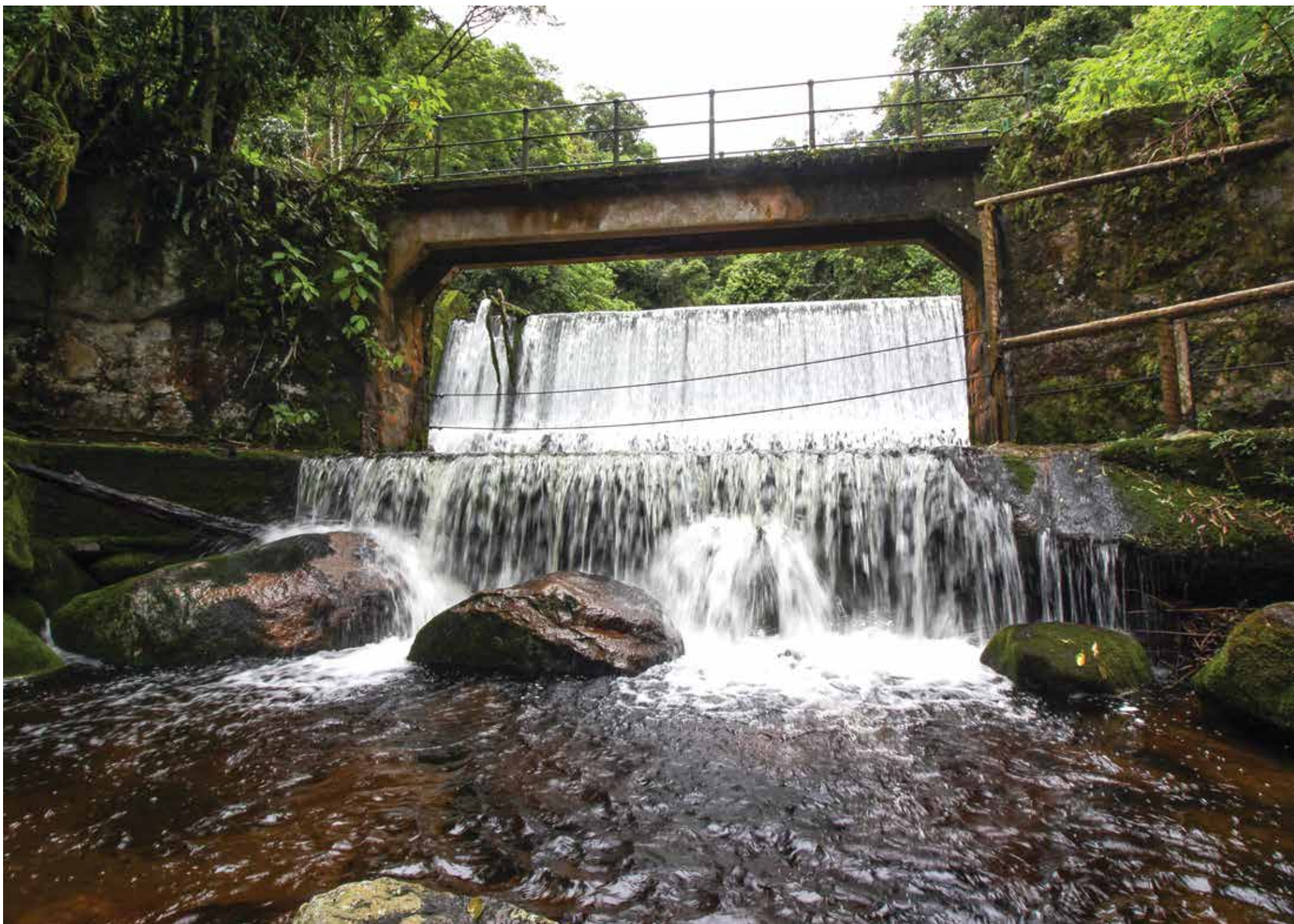
Captação de água no Parque Nacional da Serra dos Órgãos, em Teresópolis (Foto: Parque Nacional da Serra dos Órgãos)
