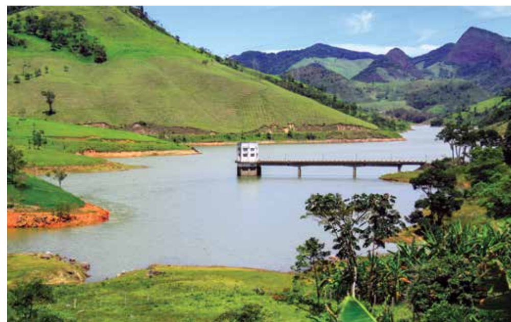
Vista aérea da bacia do Rio Macaé, em Macaé, na RH VIII (Foto: Plano de Bacia do Rio Macaé)
