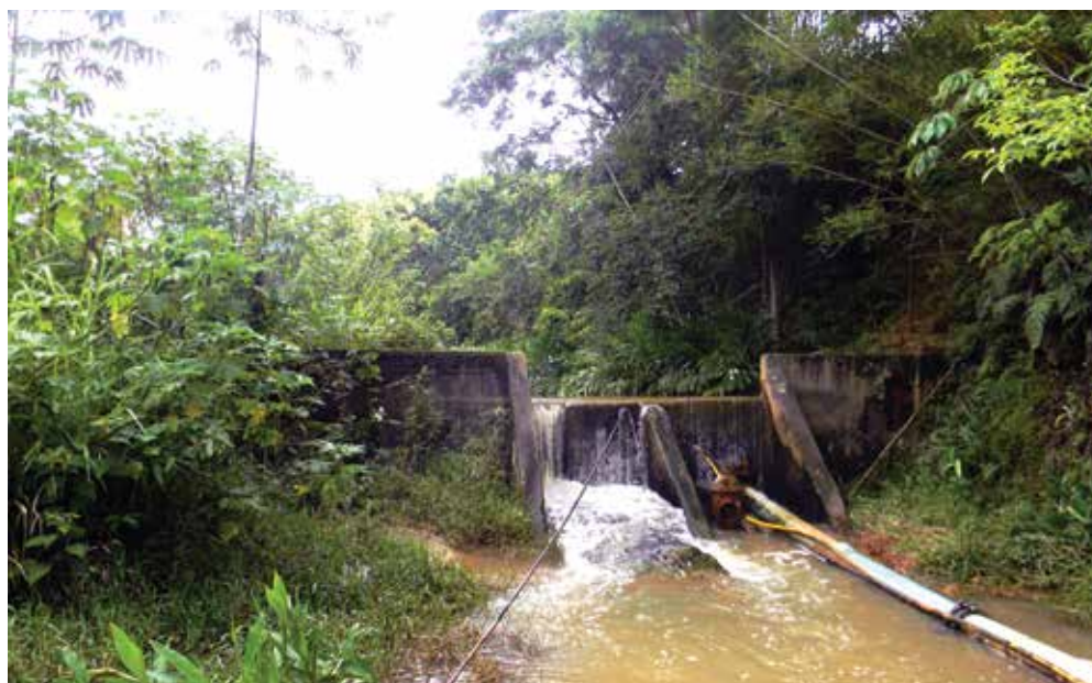
Captação de água no Córrego Fazenda do Carlito, afluente do Rio Paraíba do Sul, utilizado no abastecimento do município de Levy Gasparian (Foto: Acervo INEA)
