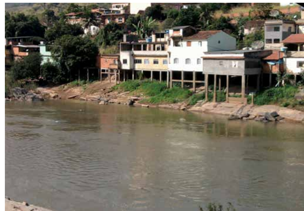
Ocupação por moradias na APP do Rio Paraíba do Sul, no Distrito de Anta, em Sapucaia. A área sofreu intensas alterações e impactos com a implantação da PCH Anta, que integra o sistema hidroelétrico de Simplicio (Foto: Ricardo Pacheco Napoleão)
