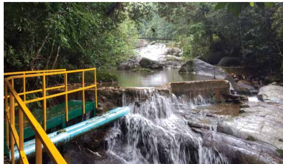
Captação de água no Rio Corisquinho, em Paraty, que compõe o Sistema Corisco de abastecimento de água (Foto: Concessionária de Abastecimento Águas do Brasil)
