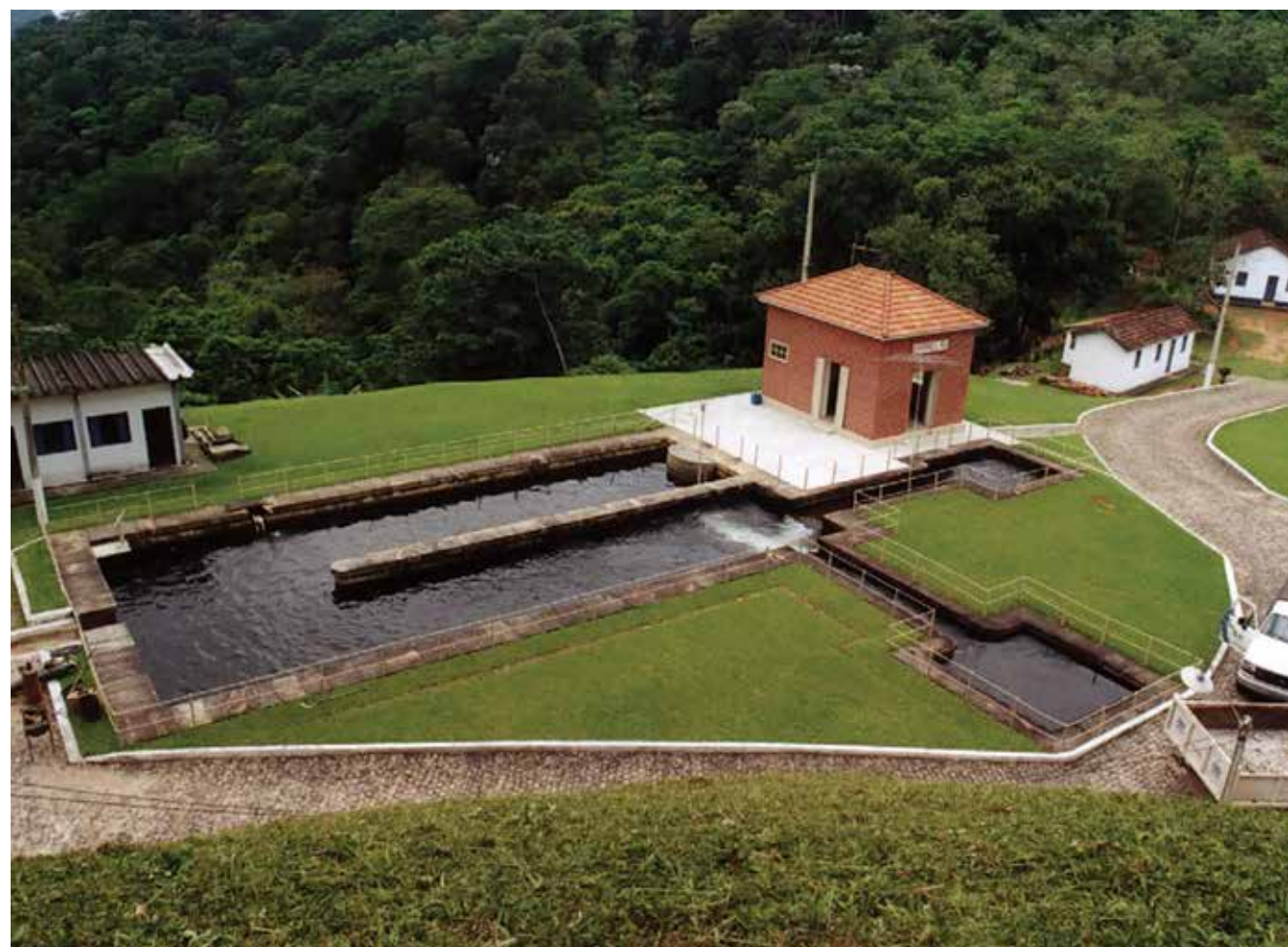
Represa de Tinguá, no Rio Tinguá, que integra o Sistema Acari de captação de água, localizado na REBIO Tinguá, em Nova Iguaçu. A área da captação e da barragem remontam ao período imperial, no século XVIII (Foto: Cosme Aquino)
