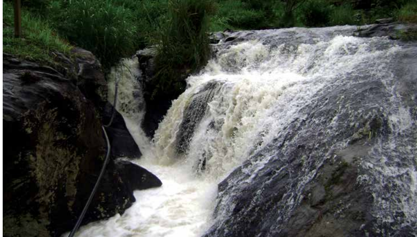
Vista da área de captação de água no Córrego Soledade, em Trajano de Moraes (Foto: João Carlos Batista)
