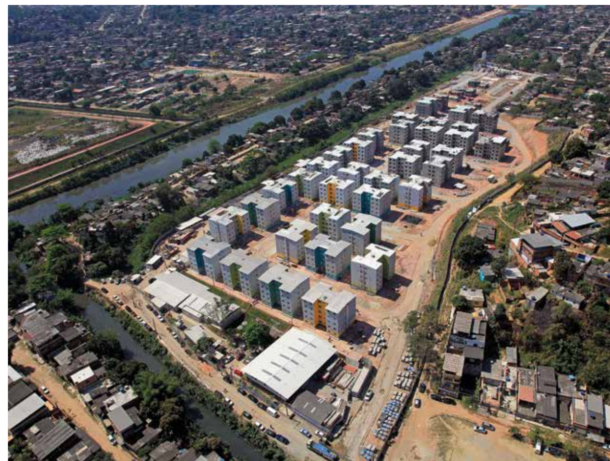
A intensa ocupação das cidades às margens dos rios representa grande impacto aos corpos hídricos, como perda de vegetação de mata ciliar e poluição. Conjunto de moradias Trio de Ouro, em Duque de Caxias, às margens do Rio Saracuruna, construído para receber população removida de área de risco de inundações (Foto: Subsecretaria de Segurança Hídrica/SEA)
