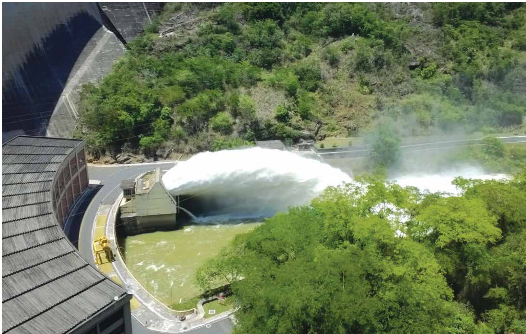
Vertedouro da Barragem do Salto do Funil, na Usina Hidrelétrica do Funil, no Rio Paraíba do Sul, em Itatiaia, integrante do Sistema Furnas de geração de energia elétrica (Foto: André Leone)
