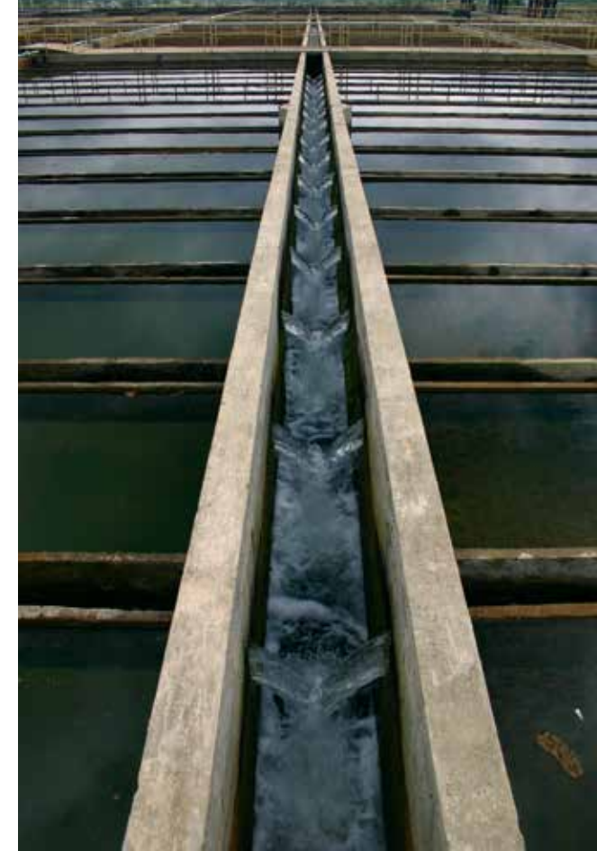
Estruturas de captação do Guandu (Foto: Cosme de Aquino)
