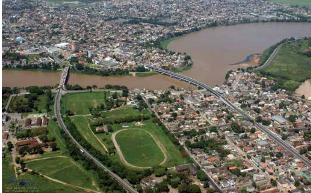
Área urbana de Campos dos Goytacazes mostrando a ponte Barcelos Martins e a Ponte Ferroviária sobre o Rio Paraíba do Sul (Foto: Acervo INEA)
