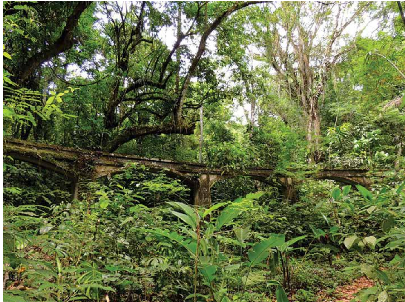
Antigo aqueduto do Pau-da-Fome, construído no século XIX, no Parque Estadual da Pedra Branca, na cidade do Rio de Janeiro (Foto: Felipe Tubarão)
