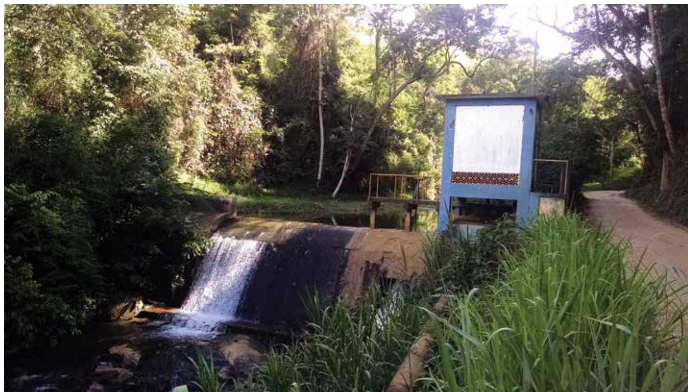
Barragem Monnerat para captação de água no Sistema Cordeiro-Cantagalo, em Cordeiro (Foto: Pedro Feijó)
