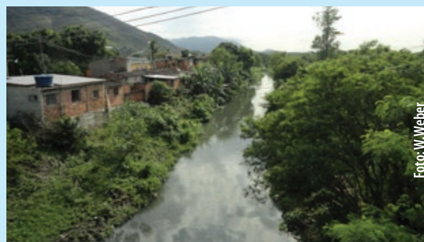
Rio Guandu-Mirim, em Nova Iguaçu: 4.268 metros de extensão
