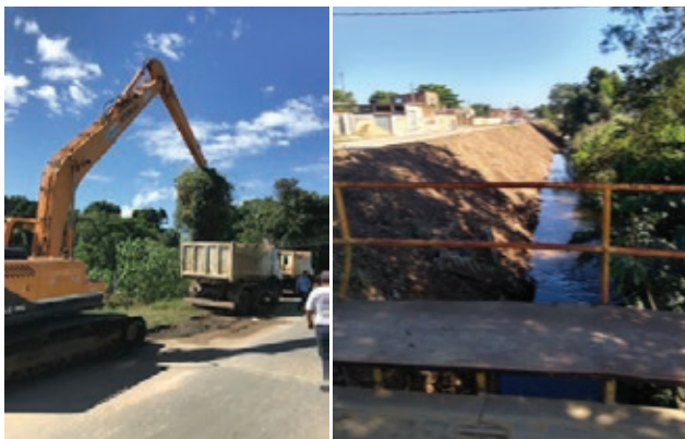
Desassoreamento do rio Sarandi, no bairro Delamare - Japeri (RJ)
