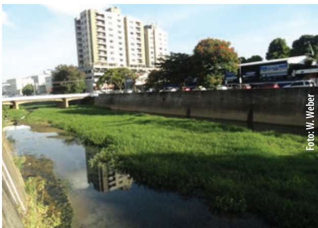
Rio Pirai, assoreado, com vegetação aquática e nos bancos de areia e terra, no Município de Barra do Pirai (RJ): 13.400 metros de extensão
