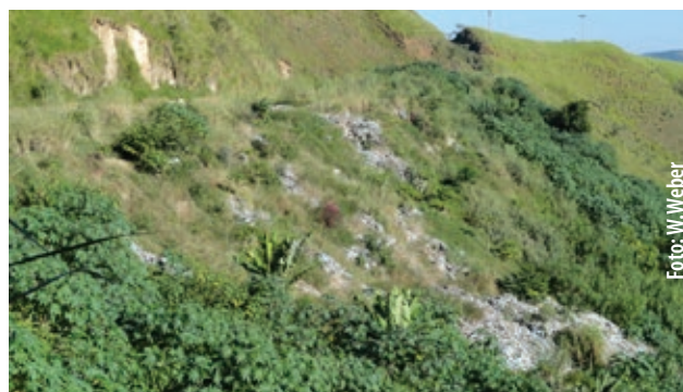
Lixão na serra de Miguel Pereira (RJ) à espera de remediação
