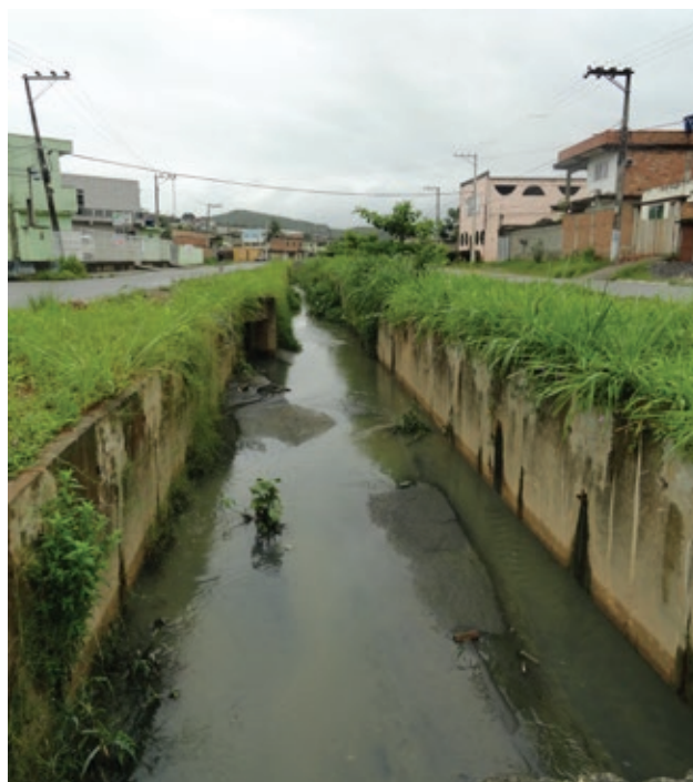
Canal Primavera atravessa o bairro de Engenheiro Pedreira e deságua no rio Guandu, após receber esgotos, águas pluviais e matéria sólida
