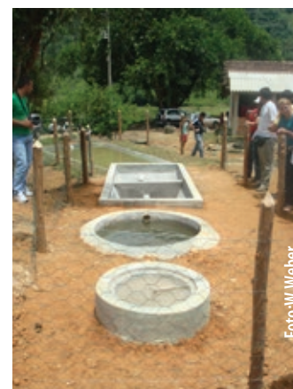
Sistema de tratamento natural dos esgotos construído na Comunidade Quilombola Alto da Serra
