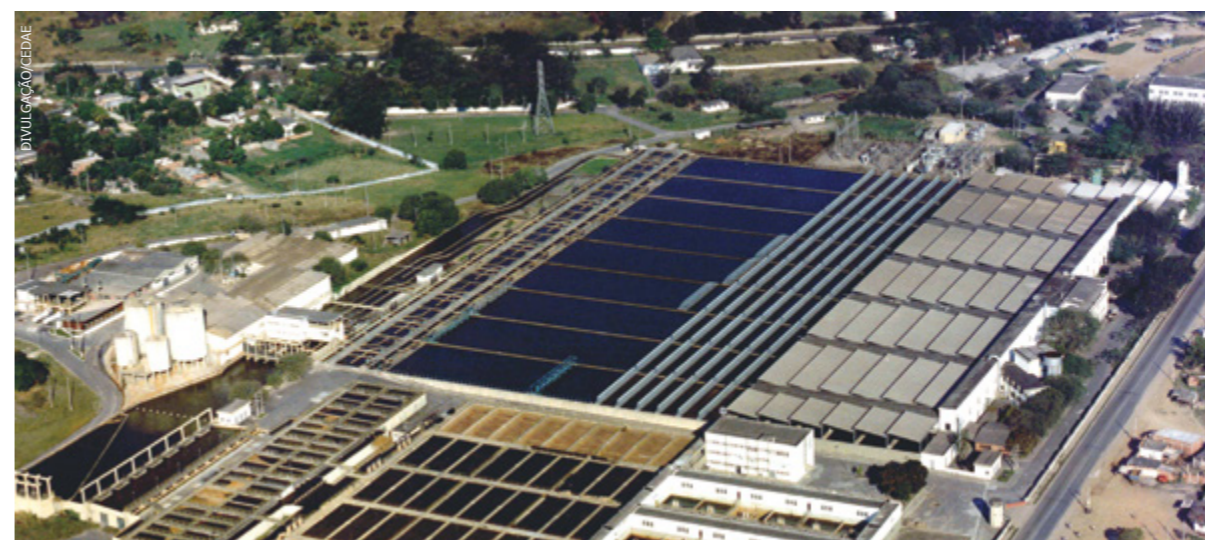
A Região Hidrográfica-II possui a ETA-Guandu, além de ser densamente povoada e ter importantes indústrias
