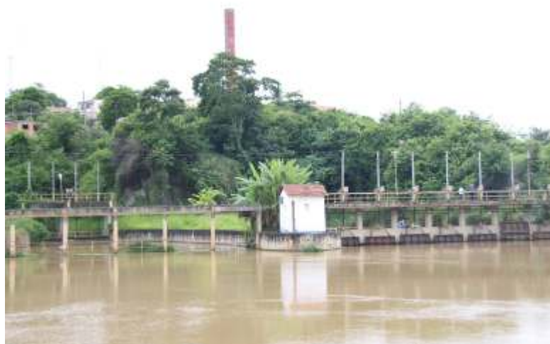
Tomada D'água Nova (esquerda) e Velha (direita). Pontos de captação das águas do Rio Guandu para o tratamento. Foto: Antonio Mendes (2020).
