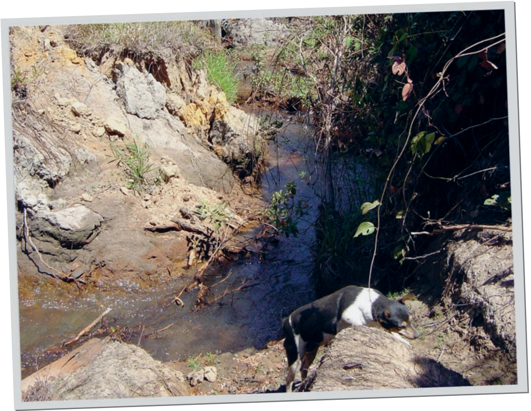
Erosão e assoreamento
