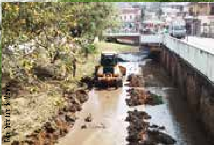
O ribeirão Santana ainda assoreado (6-01-14) e em desobstrução (setembro/14)
