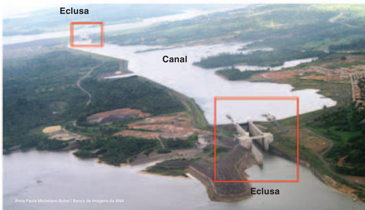
Figura 70 – Sistema de Transposição de Desnível – Tucuruí (eclusa)
