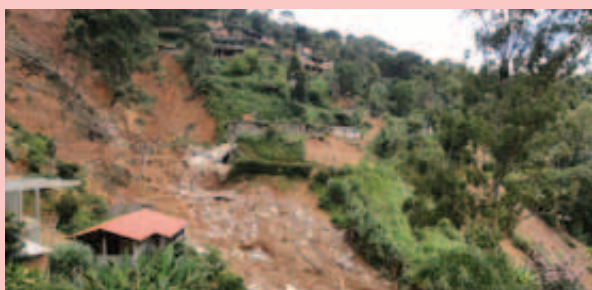
Vista da ocupação de encosta próximo à Cascata do Imbui em Teresópolis, com desbarrancamentos que atingiram casas e ruas, localizadas em declividade acima de 45°.
