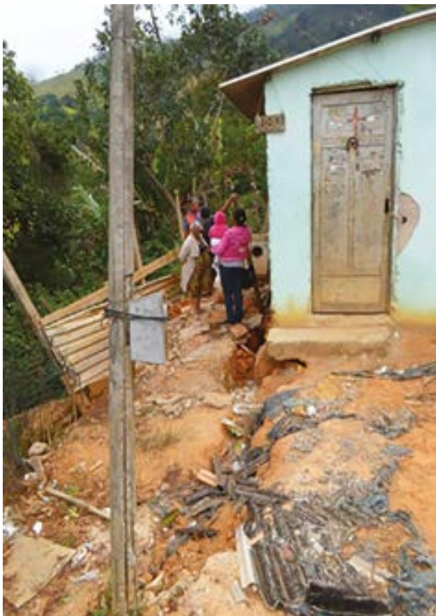
Moradia nº 880 com trincas no solo, na Rua São João Marcos, em Vassouras
