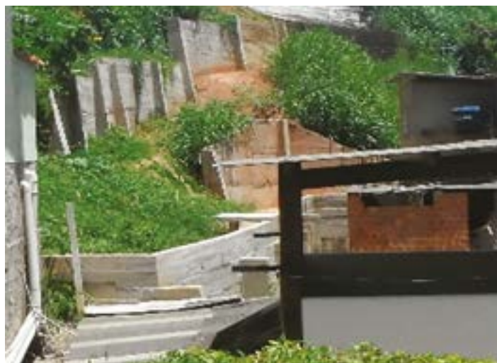
Vista da obra de contenção a partir da Rua Manoel Rodrigues da Silva, em Rio Claro (RJ)
