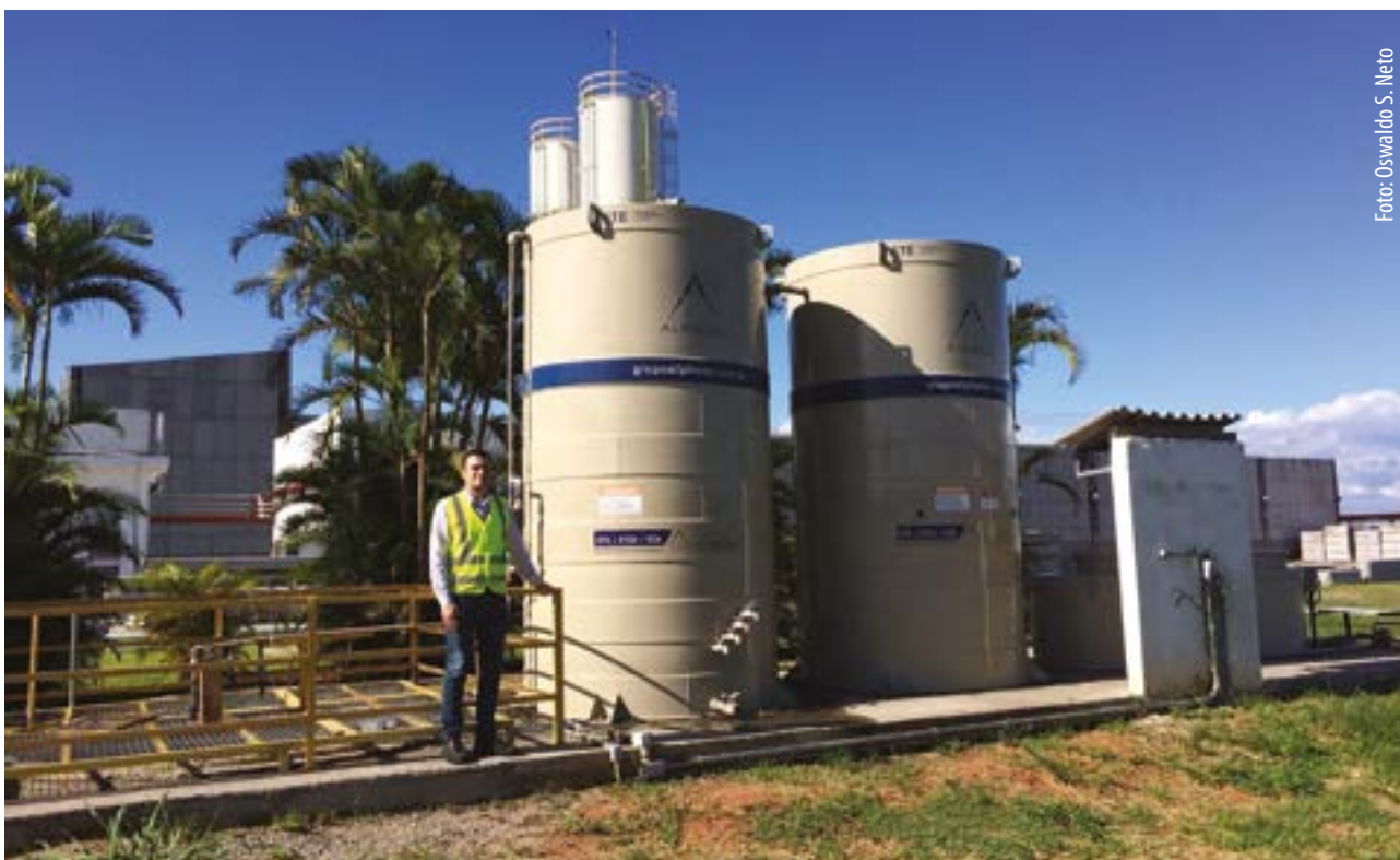
Estação de Tratamento de Esgoto (ETE) da unidade Brasilit/Seropédica (RJ): trata 20 m 3 /hora
