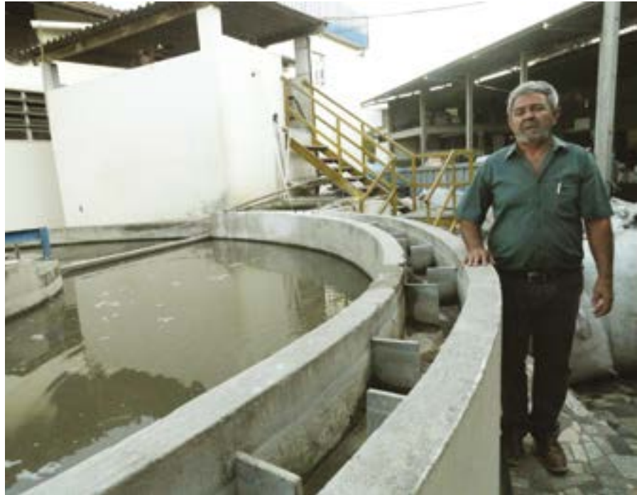
Pedro Sales explica o funcionamento da Estação de Tratamento de Água: 45 mil litros/dia
