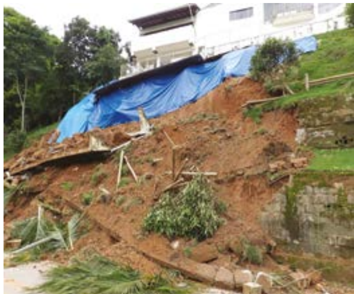
Deslizamento de talude na Rua Acadêmicos, em Pirai, põe residências em risco
