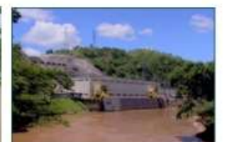
Usina Elevatória do Vigário
