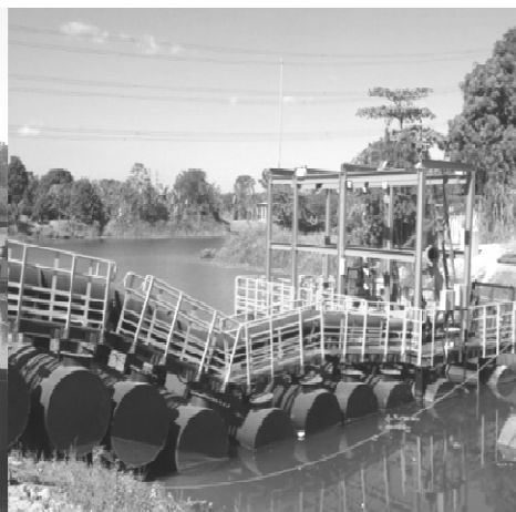
Construção de adutora de 2,2km e novo ponto de captação na FCC
