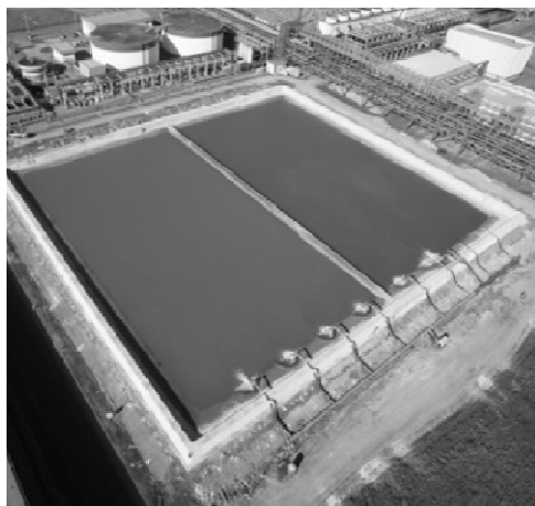
Aumento da capacidade interna de reservação (de 20.000 para 35.000 m³)
