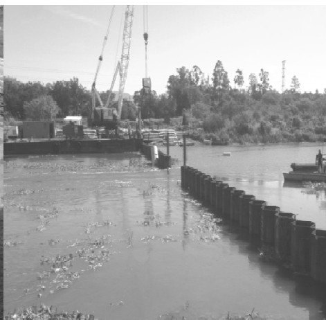
Construção de soleira submersa no Canal de São Francisco
