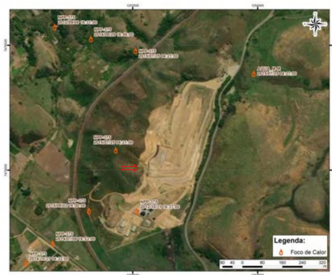
Figura 14 Foco de calor no aterro sanitário de Paracambi/RJ
