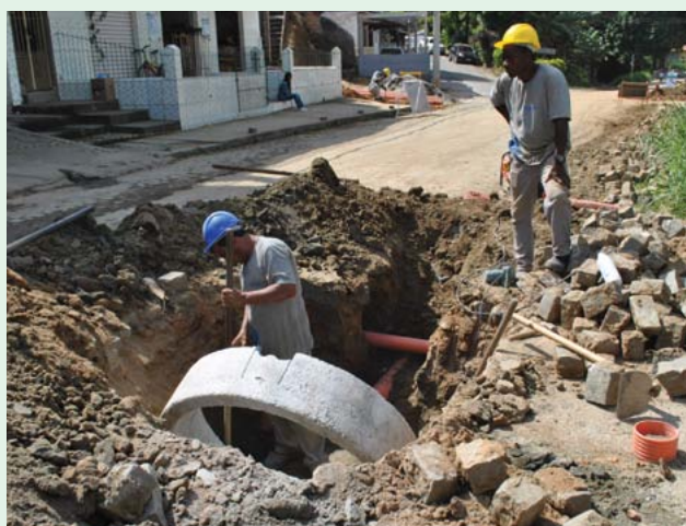
Instalação de redes no bairro Residência
