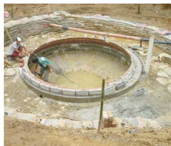
Construção em alvenaria do biodigestor de Várzea do Inhamé - Lídice (Rio Claro)
