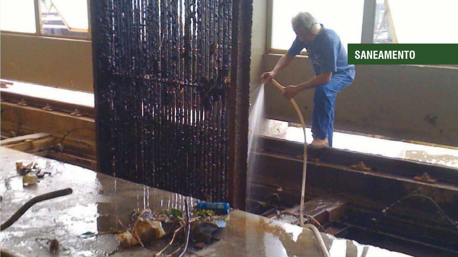
Grade de contenção de detritos que ultrapassam a barragem flutuante da Cedae
