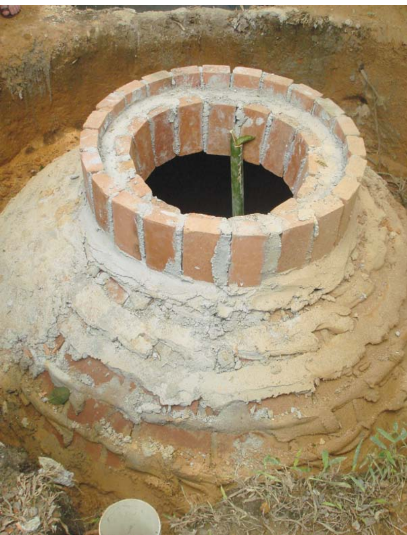
Construção em alvenaria do biodigestor de Várzea do Inhamé - Lídice (Rio Claro)
