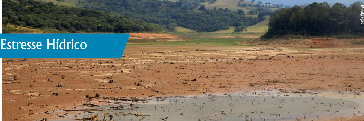
Sistema Cantareira, que sofre com a falta d'água, está operando com o volume morto
