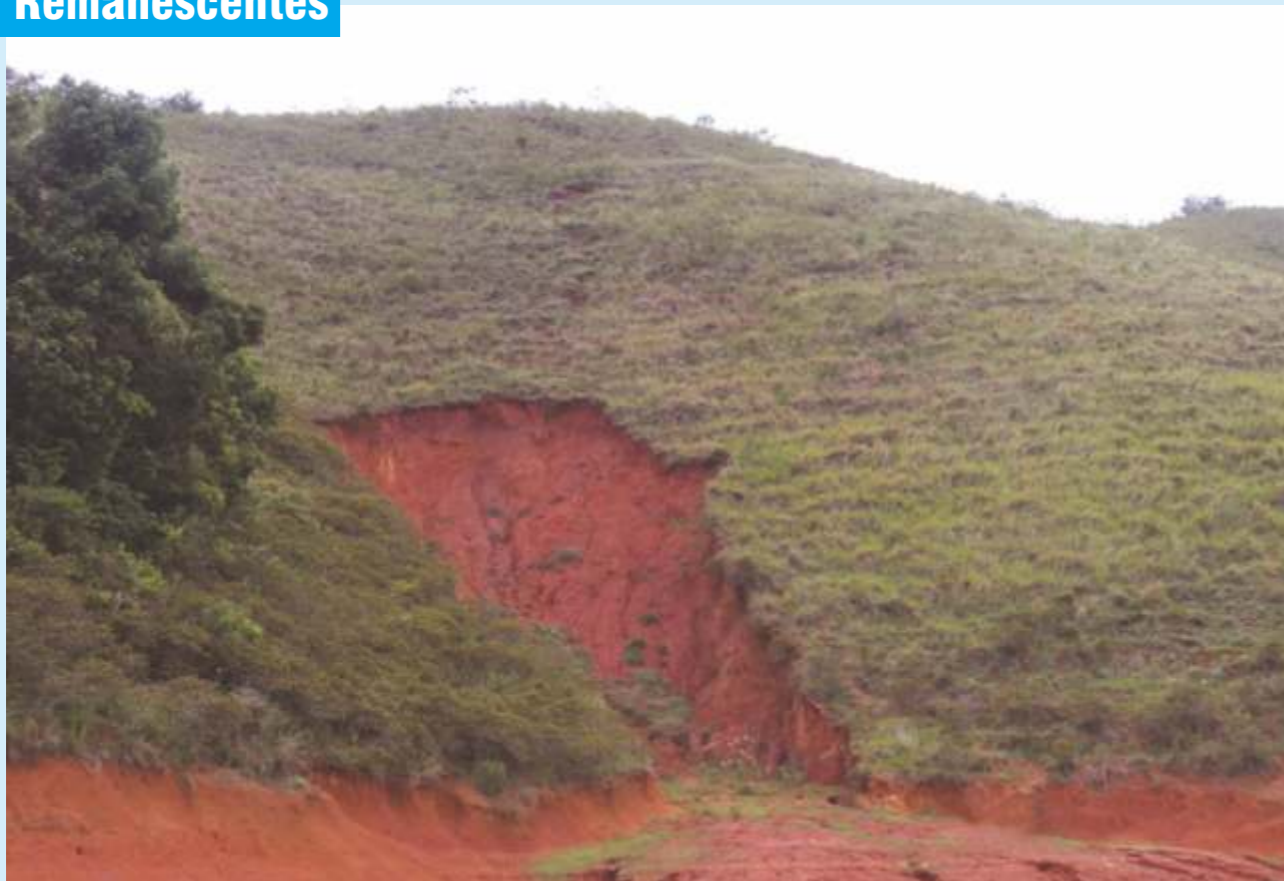
Em Rio Claro, na região do ribeirão das Lajes, voçoroca destrói o solo sem vegetação
